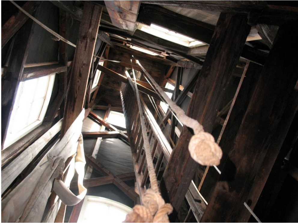
Tornet nerifrån med steg och torkade slangar
