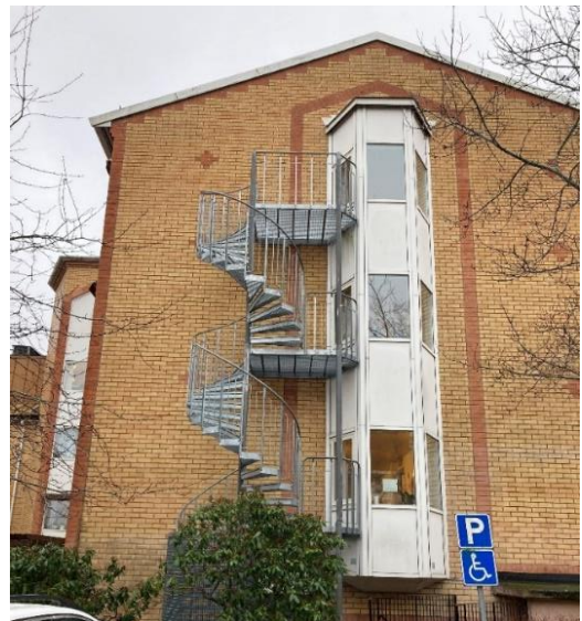
Här finns utrymningstrappor eftersom det inte går att nå lägenheter och kontorsrum med maskinstege
