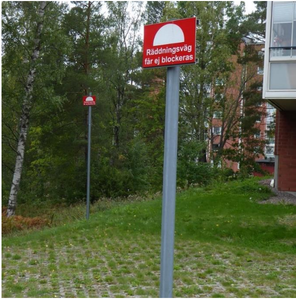
Hårdgjord yta (räddningsväg) för uppställning av maskinstege och vintertid skottad
