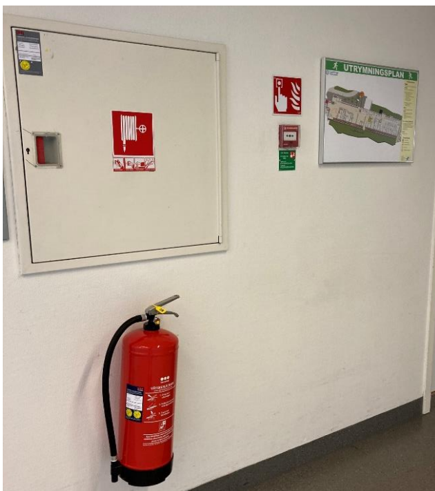
Korridor med släckare, slang, larmknapp, planritning och utrymningslarm
