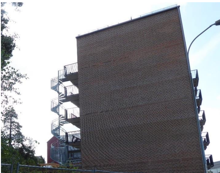
Här finns utrymningstrappor eftersom det inte går att nå lägenheter och kontorsrum med maskinstege
