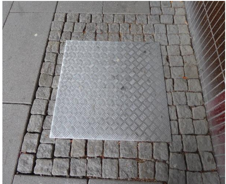
Brandventilation genom takfönster i galleria. Från garage kan rökluckor ligga gångbanan
