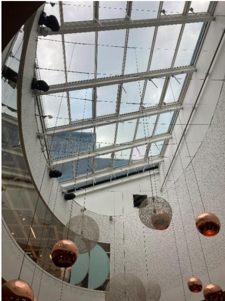
Brandventilation genom takfönster i galleria. Från garage kan rökluckor ligga gångbanan
