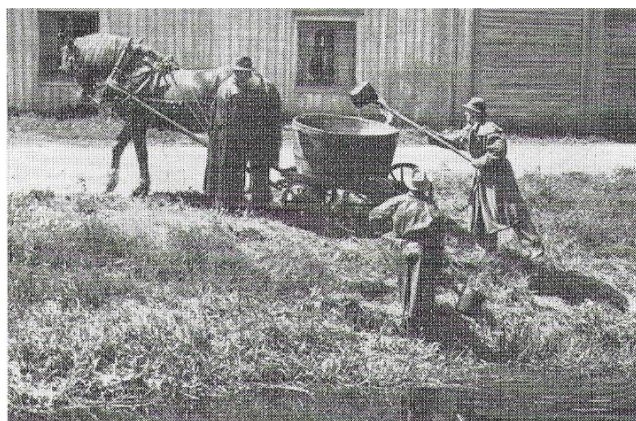
Öshink från Karlstad (nyttillverkat efter original). Dessa användes för att ösa upp vatten från öppna vattentag eller brunnar till en vattentunna. Bilden visar Kristinehamns vattenkörare och vattenösare.
