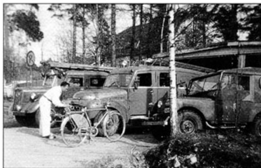
En ny brandstation/brandbod byggdes i Bruksbacken, där nu brukskontoret ligger. Rune Hagström har parkerat sin cykel mitt i fordonsparken..
