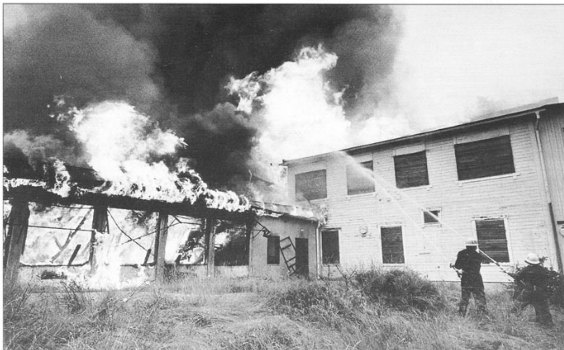
I juli 1979 brann restaurangen på Tynäs ned. Restaurangdelen var övertänd vid brandkårens ankomst.
