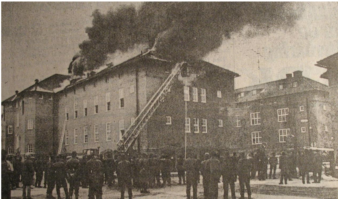
Vinden på en kasern (byggd 1922) i Linköping brann. Släckningsledaren litade på att det fanns en fungerande brandbotten som var krav vid tiden för bygget. Så var det. Halva vinden brann av. Inga vattenskador.
